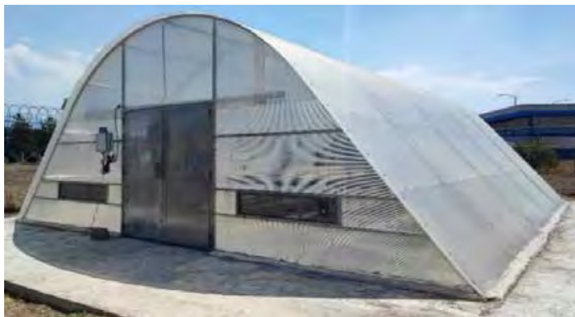
Figura 1. Secador solar tipo invernadero de forma parabólica en donde se realizaron los experimentos de secado de plátano dominico.
