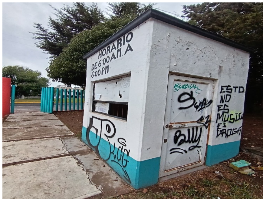
Imagen 19. Puesto de vigilancia vacío
