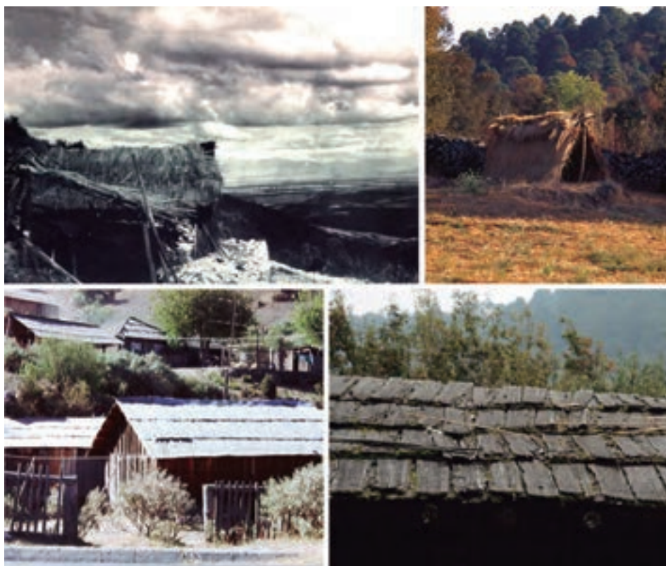
Figura 101. Ejemplos de techos de zacatón y de madera “tejamanil” identificados en el Alto Lerma. Fuente: archivo personal de Yoko Sugiura Yamamoto.
