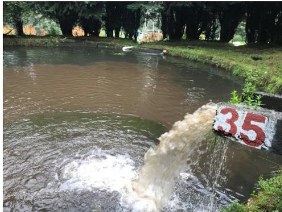
Figura 3.3. Salida de canal de lodos de los estanques de acuicultura del centro acuícola el Zarco (López-Rebollar, 2019)
