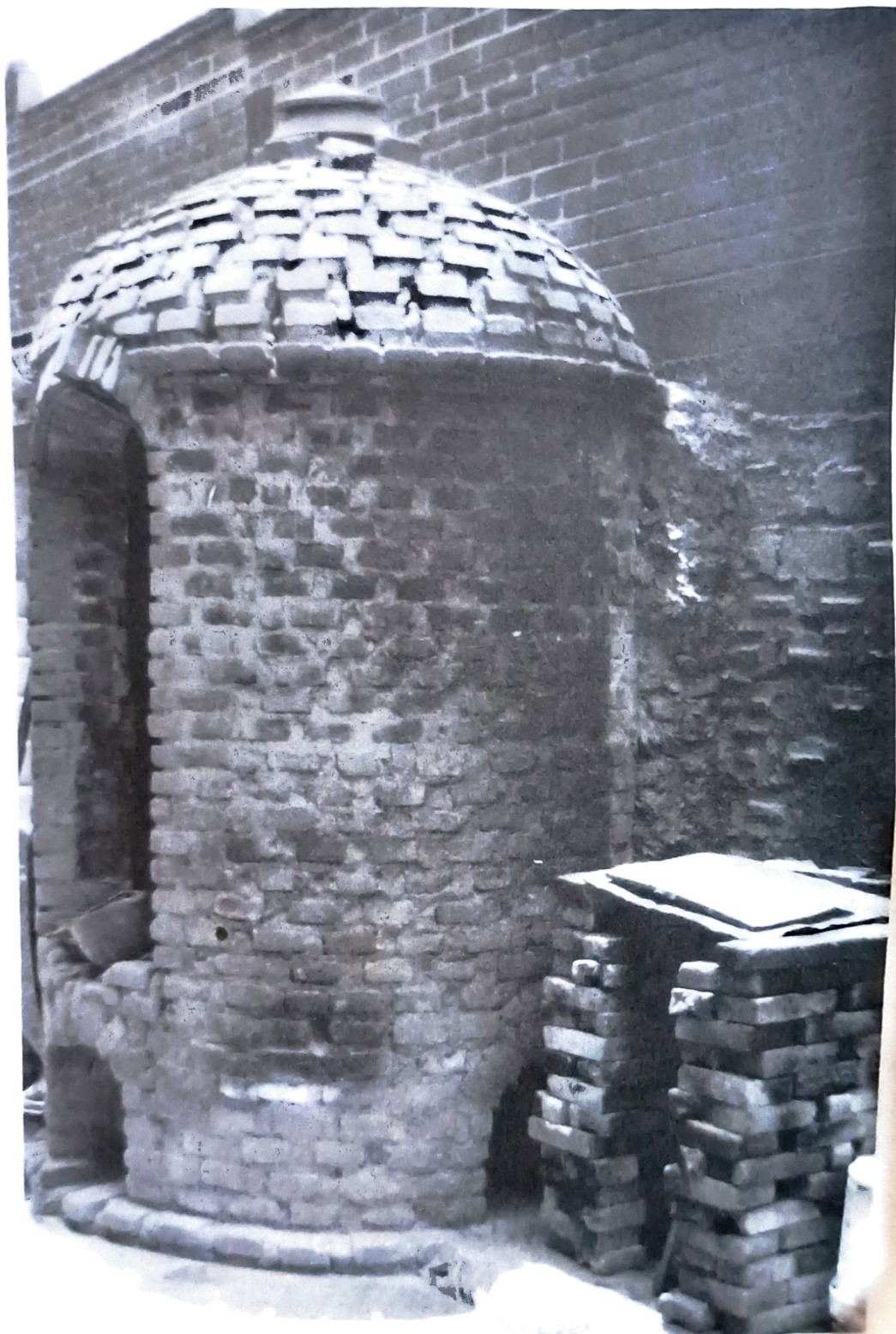
Horno para la quema de piezas grandes como árboles de la vida, sirenas, etc. Junto, podemos ver otro horno para figuras pequeñas.
