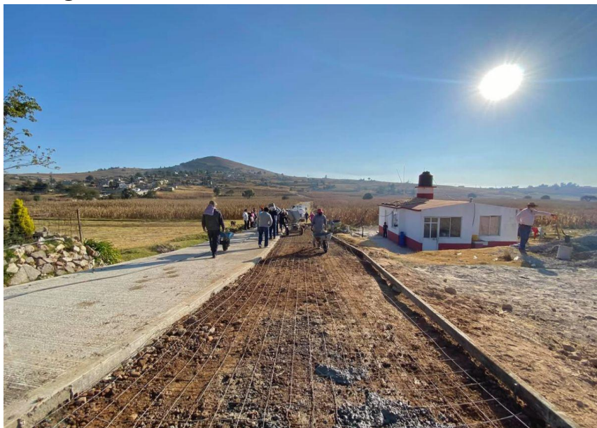
Figura 19: Construcción de una calle mediante faenas
