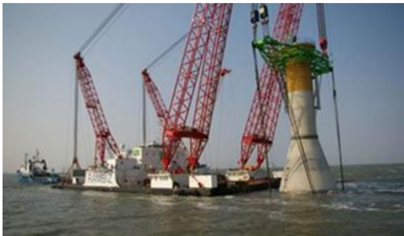
Figura 2. Cimentación de gravedad para turbinas costa-afuera. [12]
