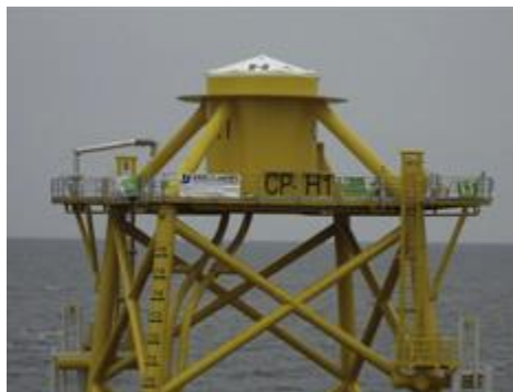
Figura 3. Cimentación tipo “Jacket”. [14]
