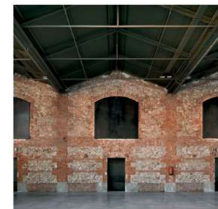
Fotografía 24 - Interior Histórico en Intervención Nave 0 - SA / SF Fuente: Matadero Madrid. Centro de Creación Contemporánea, En: https://www.mataderomadrid.org/arquitectura - Consultado el 07/10/2023
