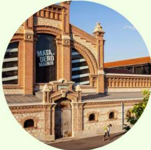
Fotografía 34 / 35 - Interior de Nave 16, apreciación de sistema mixto; muro tradicional y estructura metálica en cubierta - SA / SF
