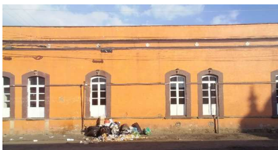
Fotografía 69 – Fachada Oeste Principal Histórica del Inmueble “Mercado Bicentenario” – Jiménez / 2023 Fuente: Elaboración Propia, 2023
