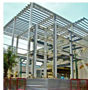
Fotografía 40 - Proceso de Construcción Cubierta - SA / SF Fuente: Toluca la Bella (En Facebook), En:
