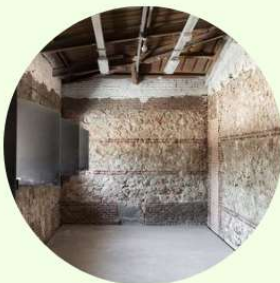
Fotografía 33 - Muro con sistema tradicional en Matadero Madrid - SA / SF
