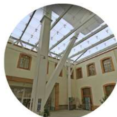
Fotografía 50 - Patio interior de Centro Tolzú, Apreciación de Sistema Contemporáneo - Jiménez / 2023 Fuente: Elaboración Propia, 2023
