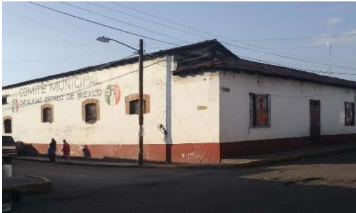
Fotografía 59 – Edificio Histórico sobre Vialidad Venustiano Carranza, uso actual como Bodega – Jiménez / 2023 Fuente: Elaboración Propia, 2023
