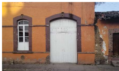
Fotografía 76 – Puerta metálica agregada al acceso principal del Inmueble “Mercado Bicentenario” – Jiménez / 2023 Fuente: Elaboración Propia, 2023
