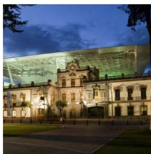
Fotografía 38 - Fachada del Centro Tolzú- SA / SF Fuente: Toluca la Bella (En Facebook), En:
