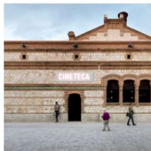
Fotografía 25 - Fachada Exterior de Cineteca - SA / SF Fuente: Matadero Madrid. Centro de Creación Contemporánea, En: https://www.mataderomadrid.org/arquitectura - Consultado el 07/10/2023
