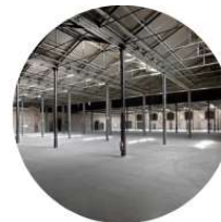
Fotografía 36 - Sistema de Cubiertas Industrial en Matadero Madrid - SA / SF
