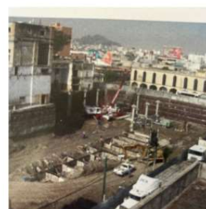
Fotografía 43 - Obras de Cimentación para Rehabilitación del hoy Centro Tolzú - SA / SF Fuente: Centro Tolzú, En:
