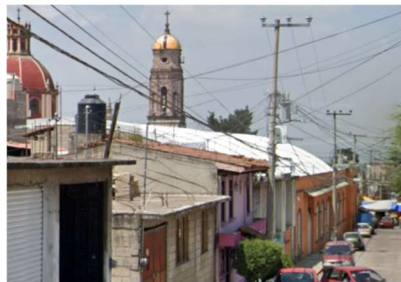
Fotografía 75 – Vista desde la Av. Niños Héroes, Apreciación de la Cubierta del Inmueble – Jiménez / 2023 Fuente: Elaboración Propia, 2023
