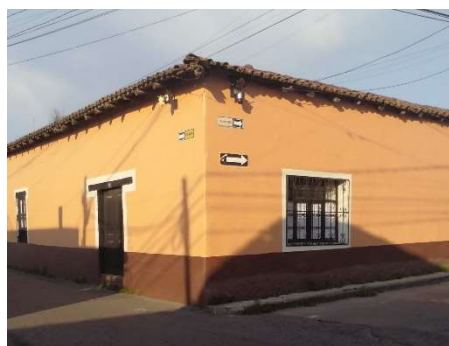
Fotografía 80 – Inmueble Histórico sobre Vialidad Vicente Guerrero – Zona 2 – Jiménez / 2023 Fuente: Elaboración Propia, 2023
