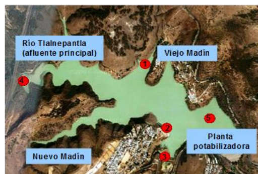
Figura 1. Presa Madín. Fuente: González-González et al, 2014.
