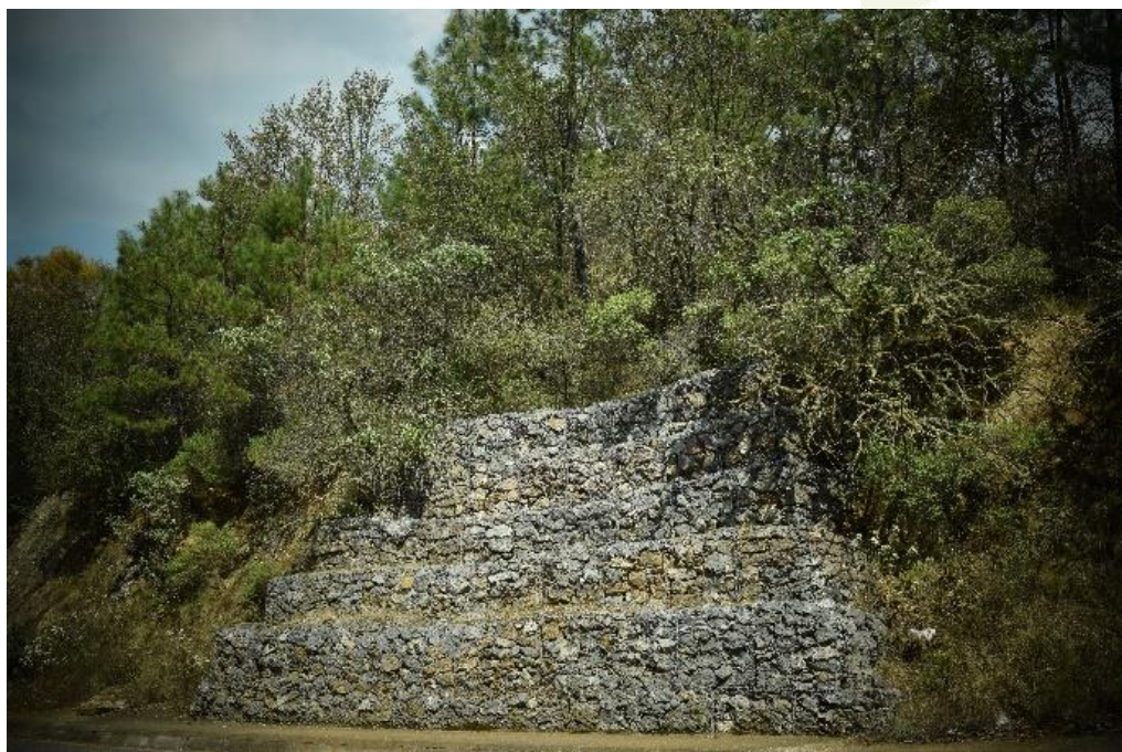
Figura 37 R. Gaviones de malla, La Barranca, Pinal de Amoles
