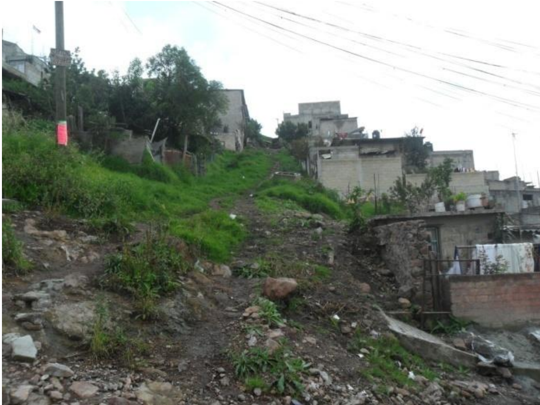
Foto no. 4 Terrenos inestables en la Colonia el Jaral. Suelo poco consolidado, con pendiente aproximada de 25 grados y saturación de agua.
