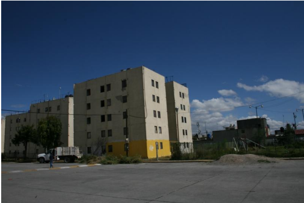
Foto no. 1 Multifamiliar ubicado en la colonia San Pablo de las salinas, en donde se presentan graves problemas de hundimiento debido a los suelos lacustres y la sobre explotación de los mantos acuíferos, aunado al problema la edificación no debería de tener más de 3 niveles de construcción debido a los suelos en los que se encuentra ubicada y este presenta 4 niveles, en la actualidad esos edificios los desalojó el infonavit por el riesgos que implicaba habitarlos.
