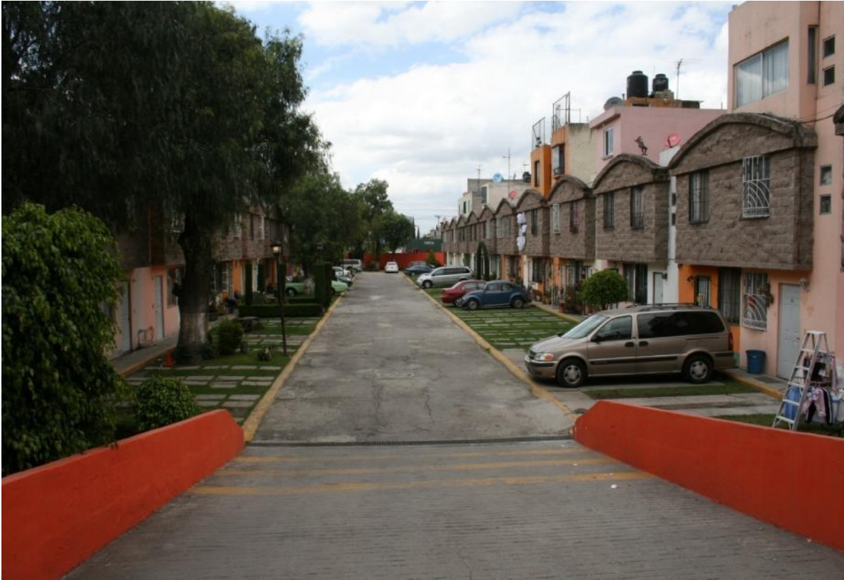
Foto no. 15 Zonas habitacionales en riesgo de inundaciones: Vialidad José López Portillo y Calle Laureles.
