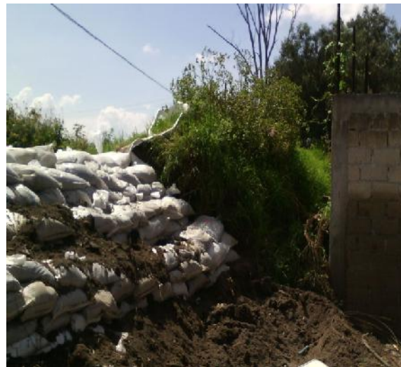
Fotos no 29 y 30 En la primera imagen se muestra el encostado de una altura de 2 m. a la orilla del canal mariscala que pasa por la Colonia Fuentes del valle, mismo que se desbordo colapsando el muro natural, en la segunda imagen se muestra el mismo encostado pero del otro lado y se puede apreciar la marca de inundación en muro el cual tiene una altura de 2 m. aproximadamente, fotos tomadas el día 20 de Septiembre del 2015.
