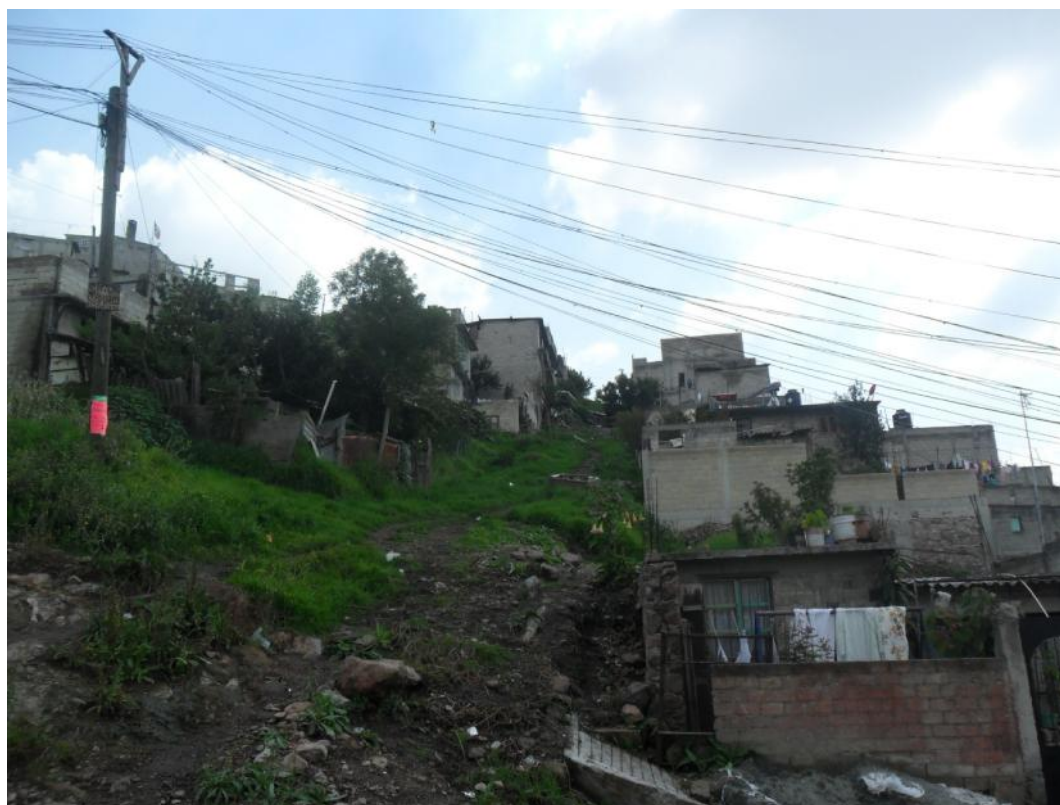
Foto no 16. Colonia al Paraje en donde se observan asentamientos irregulares con riesgo a derrumbe por el grado de pendiente en donde se encuentran ubicados.
