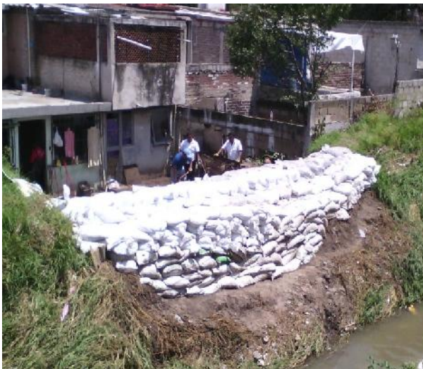
Fotos no 29 y 30 En la primera imagen se muestra el encostado de una altura de 2 m. a la orilla del canal mariscala que pasa por la Colonia Fuentes del valle, mismo que se desbordo colapsando el muro natural, en la segunda imagen se muestra el mismo encostado pero del otro lado y se puede apreciar la marca de inundación en muro el cual tiene una altura de 2 m. aproximadamente, fotos tomadas el día 20 de Septiembre del 2015.
