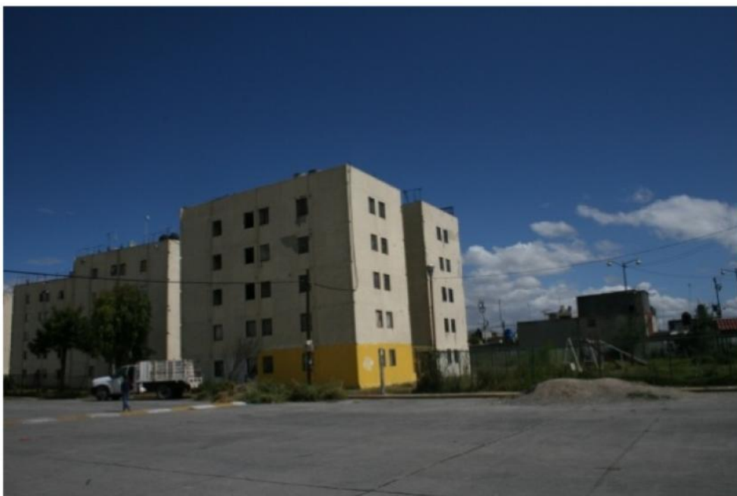
Foto no. 7 Inclinación de edificios por hundimiento en el Fraccionamiento Jardines San Pablo
