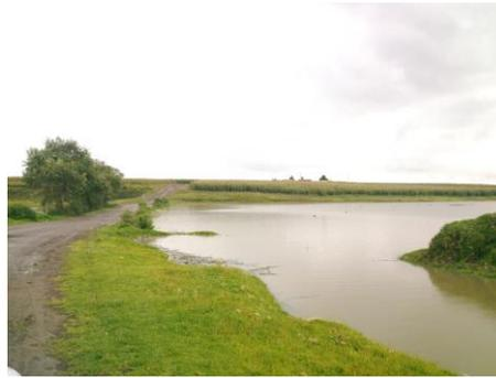
**Acción a realizar:** Desazolver y levantar paralelamente al camino un bordo que delimite esta con la presa y evitar que el nivel hidrico revase la corona del camino.
