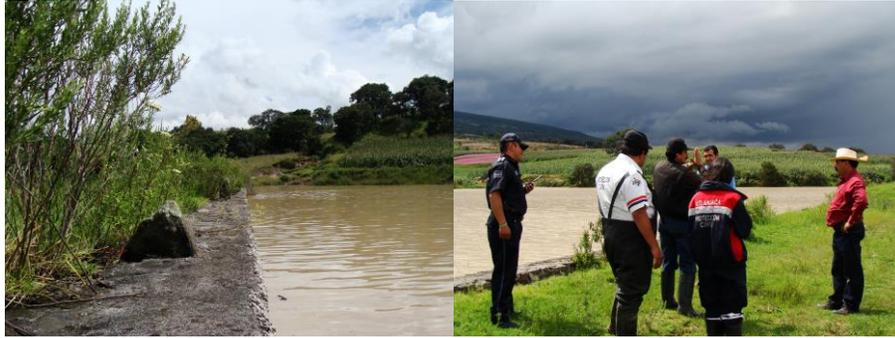
**Acción a realizar:** Retirar en una franja lineal de 100 ml la corona de la cortina para colocar nuevo material y ser compactado en capas de 20 cm para reforzarla, a partir de la compuerta al Sur.
