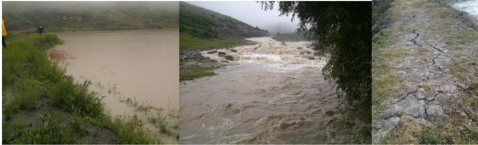
**Acción a realizar:** hacer una cala en la corona del bordo de 2 m de largo por el ancho que tenga la corona, con ello identificar si las grietas son superficiales o profundas, de ser superficiales retirar los 80 cm de espesor que tiene de azolve y colocar nuevo material pétreo y tierra arcillosa para tener una nueva corona, compactando en capas de 20 cm.
