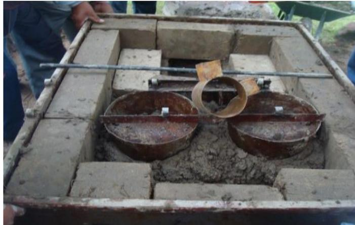
Una vez dentro los blocks, colocamos los demás moldes para las hornillas y rellenamos la parte interior con la mezcla previamente preparada.
