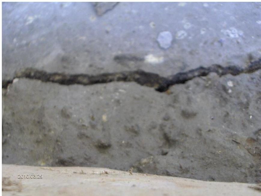
Figura 11: Ruptura del piso de un SES 2
