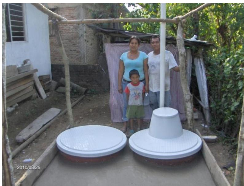
*Foto 3: Sanitario Ecológico Seco terminado, la caseta está construida con materiales acordes al entorno*
