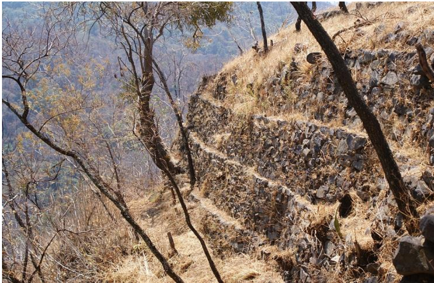
Figura 40. Muro de contención de la plataforma principal.
