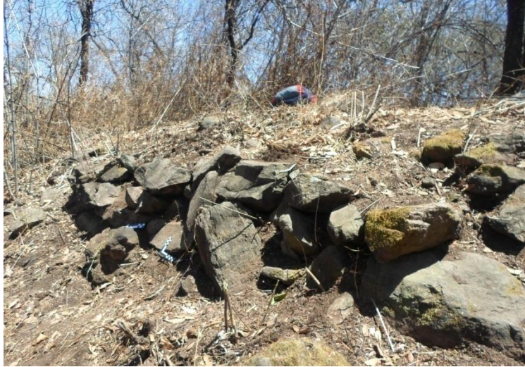
Figura 39 Vista del muro de contención Oeste y parte de la plataforma.
