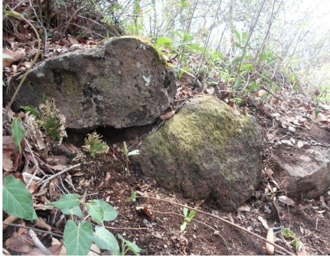
Figura 46 Fragmento de un muro de contención.
