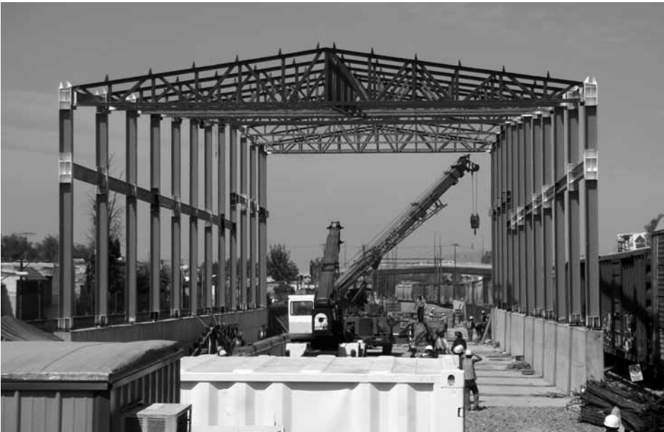
Construcción del tren suburbano Buenavista-Cuautitlán.
