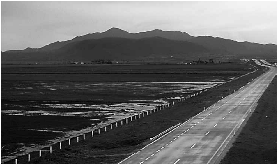
Terreno del proyecto plataforma logística de Tizayuca (PLATAH).
