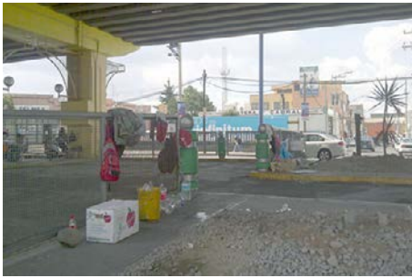
Imagen 20. Parte baja puente vehicular. Toluca, Edo de Méx
