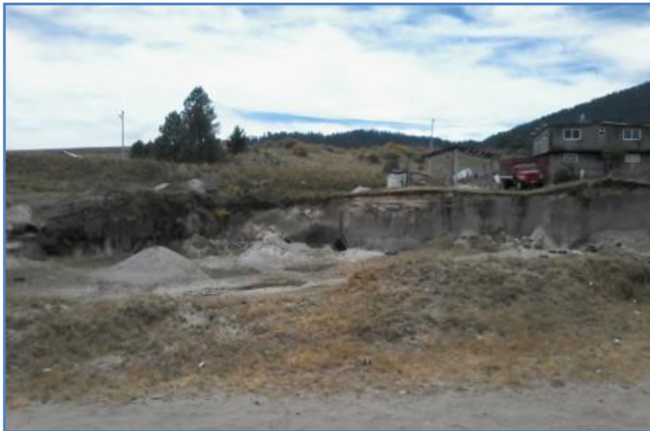
Figura 24. Asentamientos sobre terreno frágil
