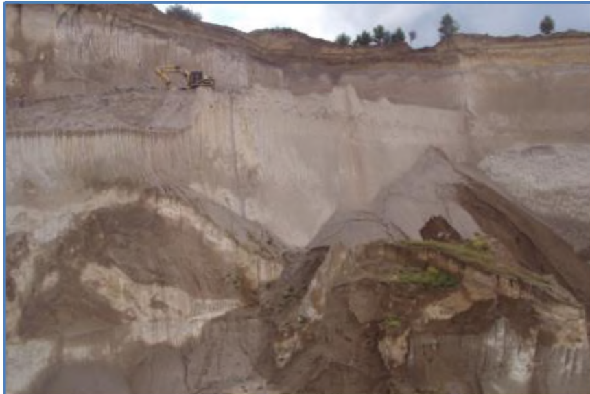
Figura 11. Banco de material, ubicado en la limítrofe con la carretera Toluca–Temascaltepec
