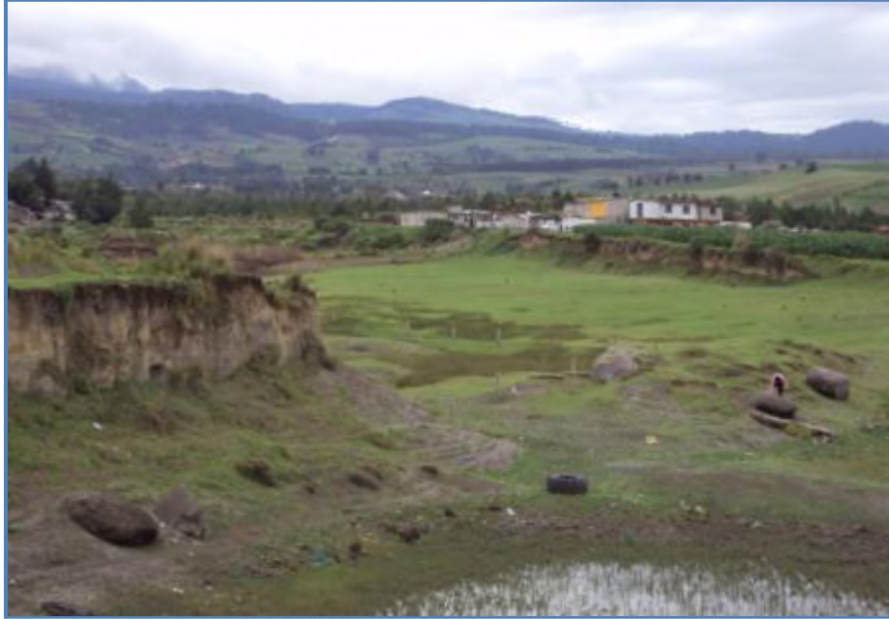
Figura 13. Socavón con indicios de exploración de área
