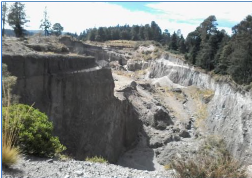
Figura 29. Socavones encontrados A
