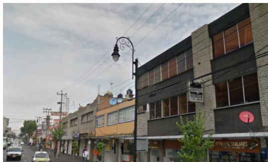
Foto 13. Poste de iluminación tradicional sobre la Av. Morelos.
