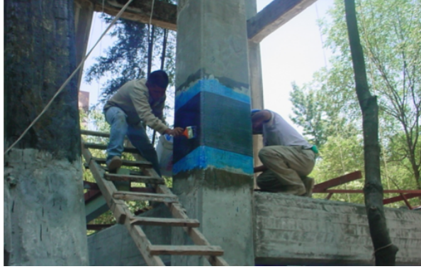
Figura 5. Aplicación de fibras para encamisar columna de caballete
