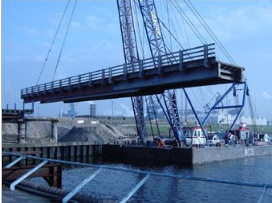
Figura 1.8. Montaje de un módulo JSB Mkl (Janson Bridging, 2010).
