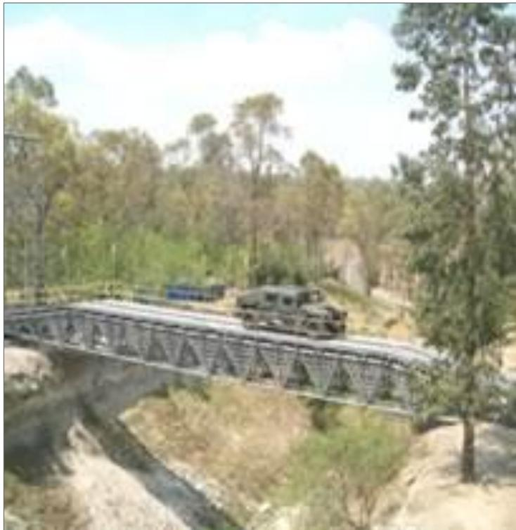
Figura 1.31. Puente militar metálico desmontable (SEDENA, 2010).
