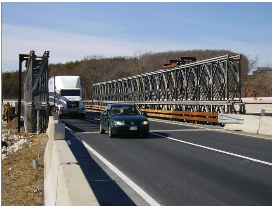
Figura 1.3. Cargas móviles transitando por un puente vehicular construido con el sistema Mabey Bridge (Mabey, 2008).
