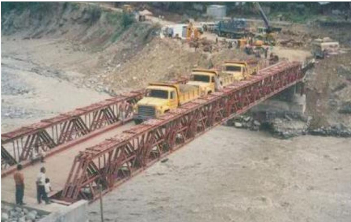
Figura 1.30. Construcción de puente vehicular utilizando el sistema PARMS (SAC, 2006).
