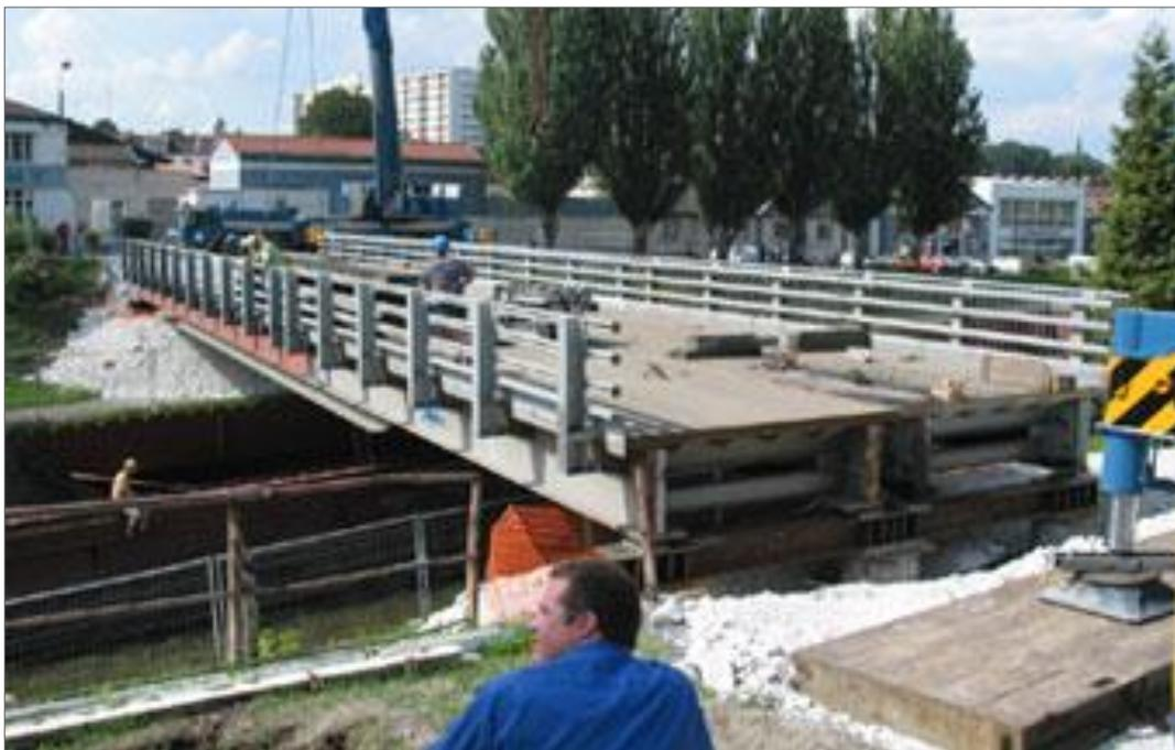
Figura 1.9. Construcción de un puente de dos carriles de circulación con el sistema JSB Mkl (Janson Bridging, 2010).
