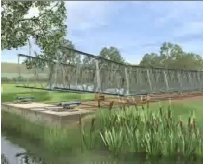
Figura 1.4. Estructura guía para lanzar el puente (Mabey, 2008).
