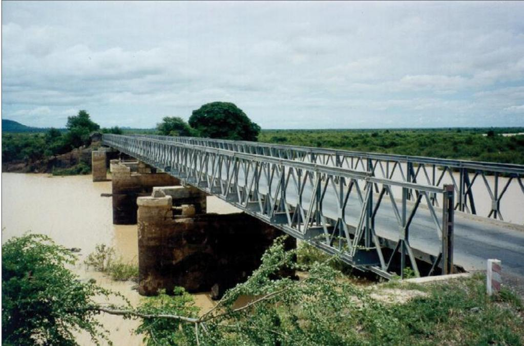
Figura 1.2. Puente vehicular terminado utilizando el sistema modular Mabey Bridge (Mabey, 2008).
