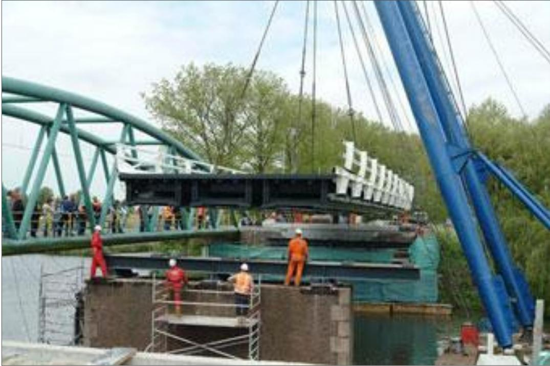
Figura 1.10. Montaje de puente con tres carriles de circulación utilizando módulos JSB MkII (Janson Bridging, 2010).
