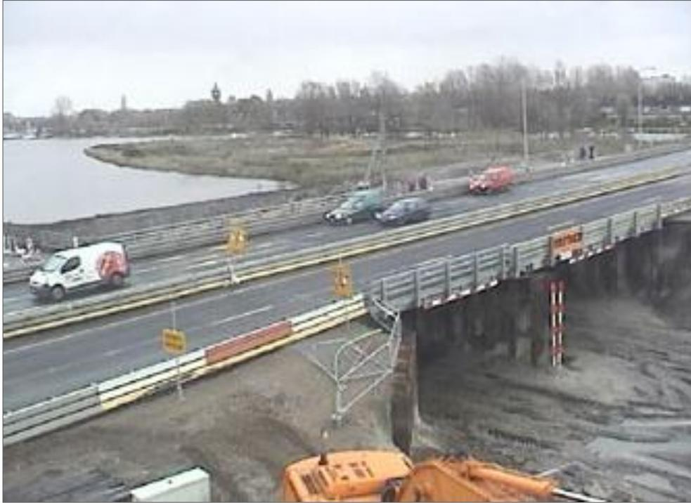
Figura 1.13. Puente de dos carriles de circulación construidos con el sistema JSK MkI (Janson Bridging, 2010).
