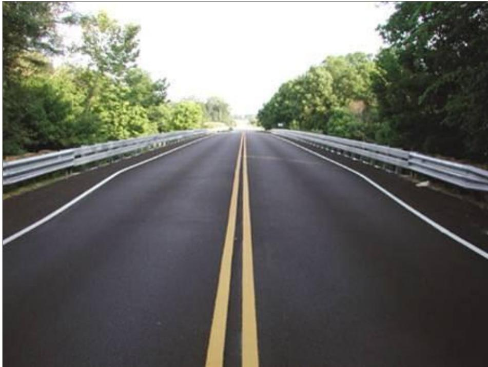
Figura 1.27. Superficie final de asfalto sobre paneles de fibra de vidrio (Guardian Bridge, 2010).
