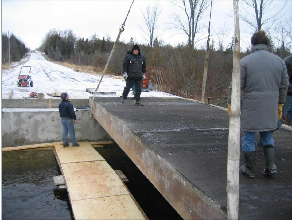
Figura 1.26. Superficie de rodamiento a base de paneles de fibra de vidrio (Guardian Bridge, 2010).
