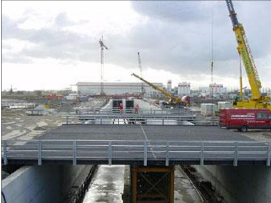
Figura 1.14. Puentes de varios carriles de circulación construidos con el sistema JSK MkII (Janson Bridging, 2010).
