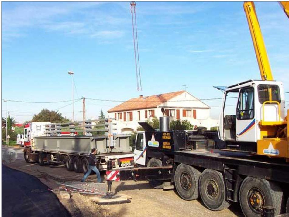
Figura 1.20. Vehículos de transporte y montaje del sistema modular (Unibridge, 2009).
