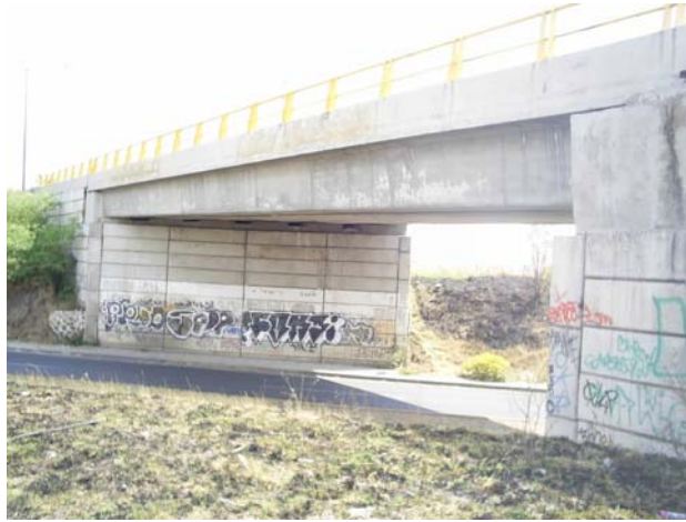
Figura 2.8. Muro mecánicamente estabilizado
