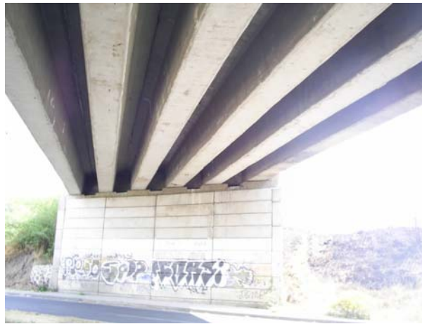
Figura 2.5. Vista de las traveses en el Puente de estudio.
