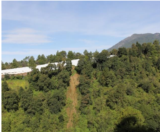
Fotografía 9: Deslizamiento de material en laderas de origen volcánico
