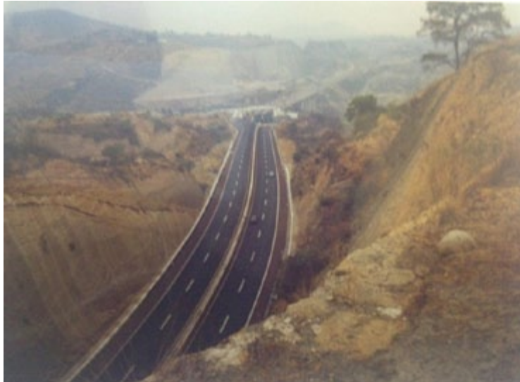
Terreno de la Localidad de San Cristóbal Texcalucan, antes de la Construcción de Bosque Real (Vista a la Autopista Chamapa- Lechería) (Expediente de Autorización del Conjunto Urbano)
