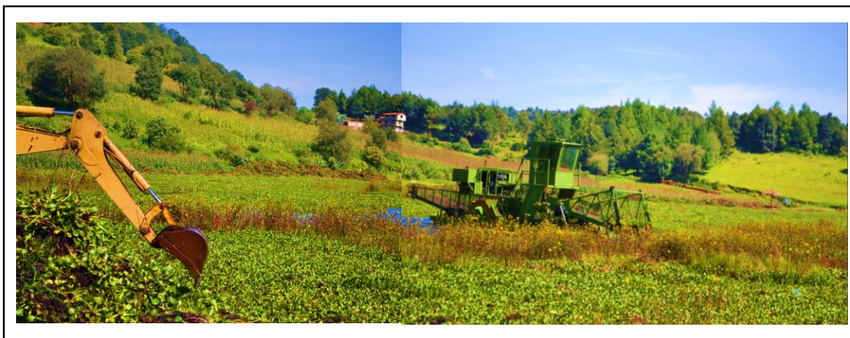
Fotografía N° 1. Desazolve de la Laguna de San Miguel Almaya.
