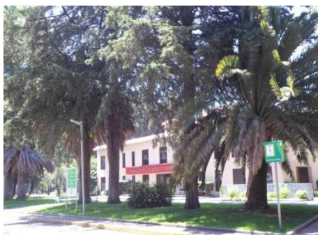
Figura 55. Edificio administrativo. En su interior alberga las oficinas del parque, PRAPAEM, la enfermería y los baños. (Elaboración propia).
