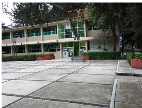
Figura 38. Gimnasio de spinning. Al frente se aprecia también su explanada. (Elaboración propia).
