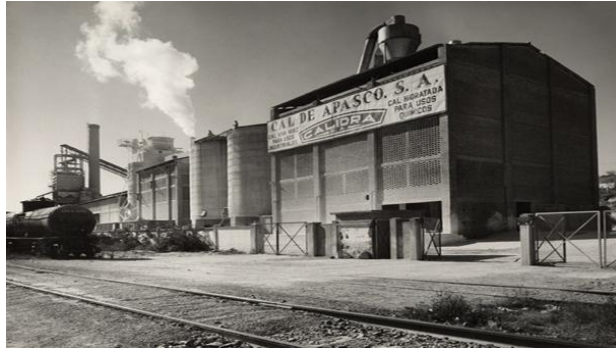
Fig. 7. Construcción de Cal de Apasco Planta II. (1950)
