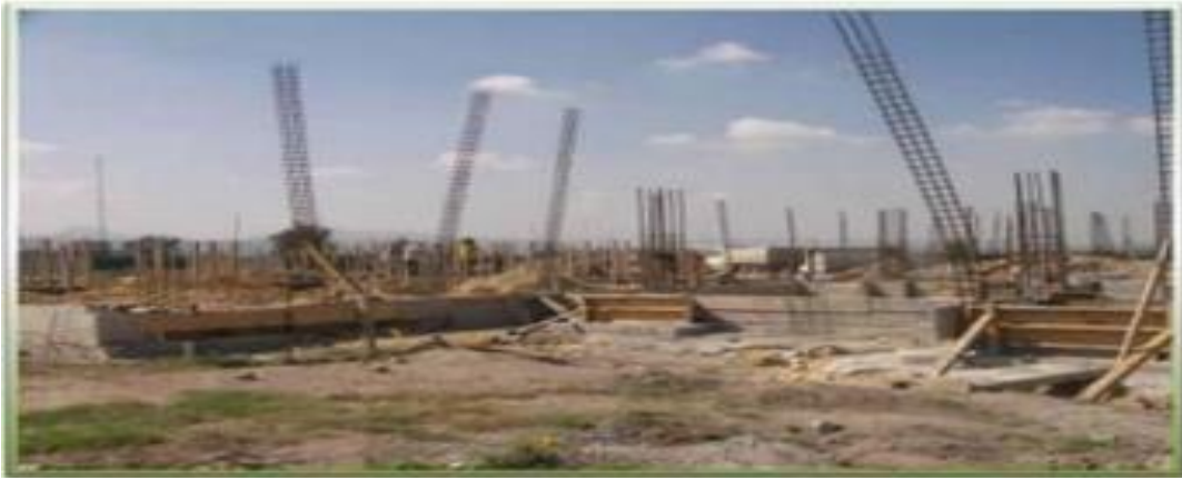
Figura 4 Construcción del edificio de Posgrado (Plan de Desarrollo Institucional, CU UAEM Texcoco, 2015).
