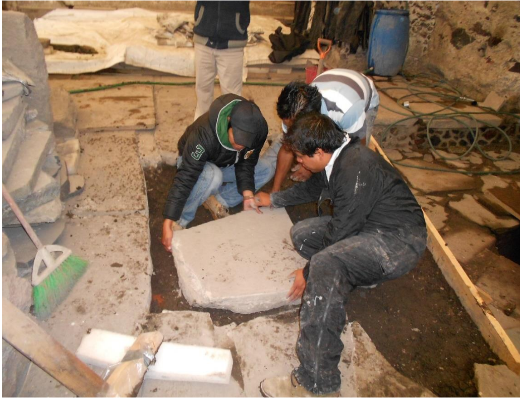
Figura 32.Reintegración de pisos.
