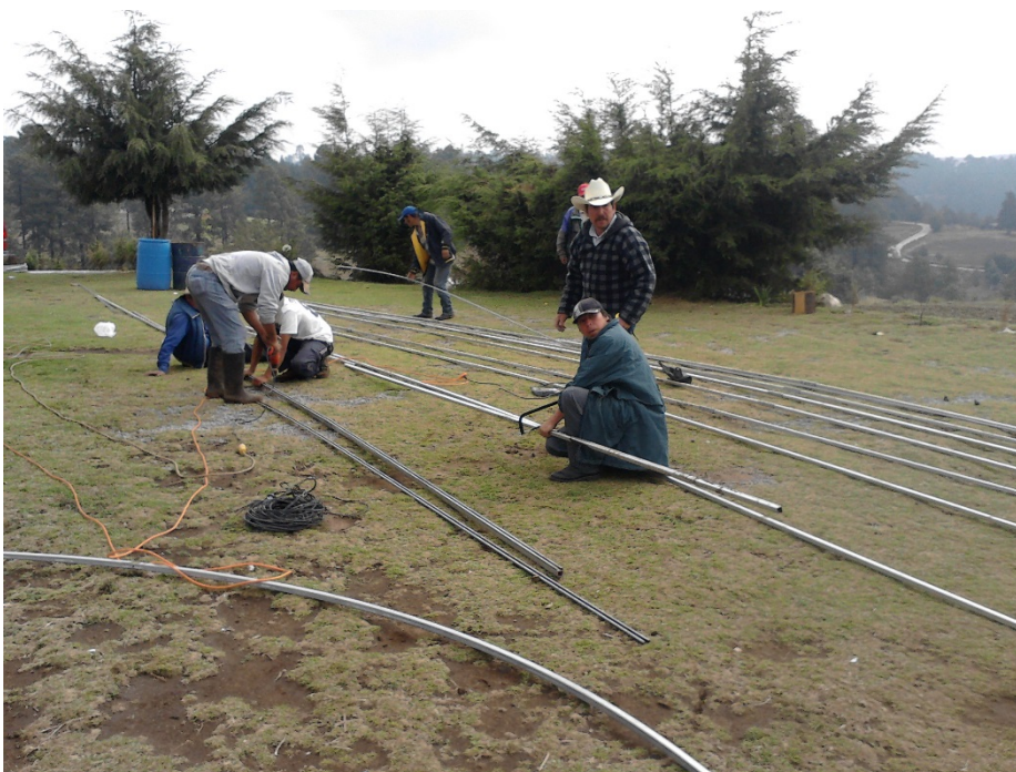
Imagen 18. Construcción de invernaderos.
