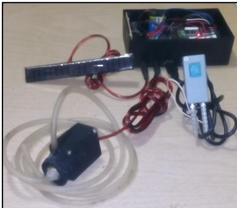
Figura 3.13. Sistema de autónomo de monitoreo y riego.
