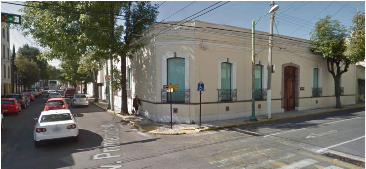
Figura 9. Esquina de Calles Von Humboldt y 1º de Mayo. Señalética y rampas que invitan a usuarios de sillas de ruedas a circular en aceras con el acceso bloqueado (Elaboración propia, fragmento de imagen Street View de Google Maps).
