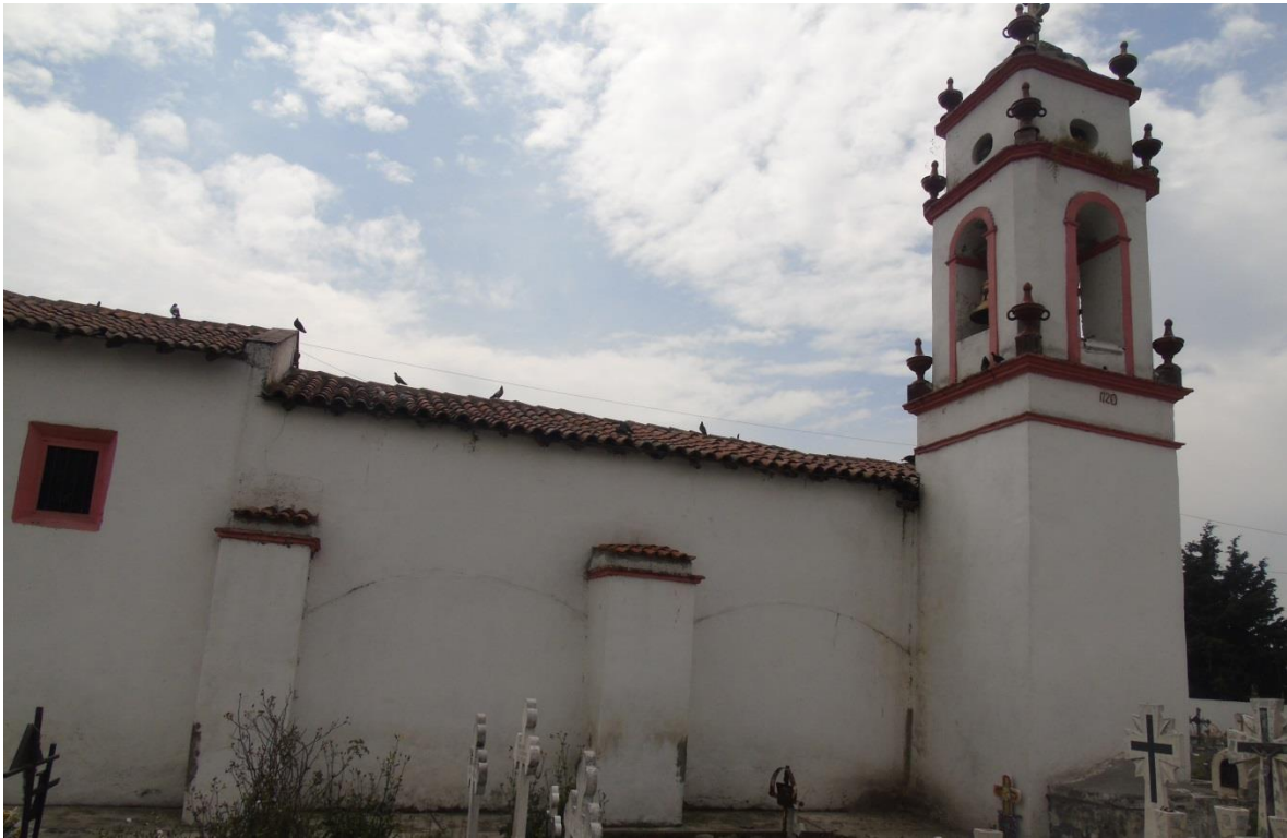
Fig. 12 Muro lado norte. Foto tomada por Olivia García Guadarrama 2015
