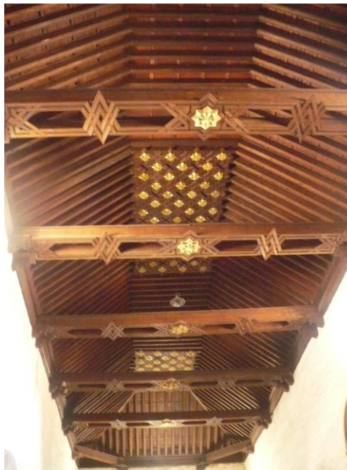
Fig. 3 Convento de San Francisco, Tlaxcala. Techumbre mudéjar
