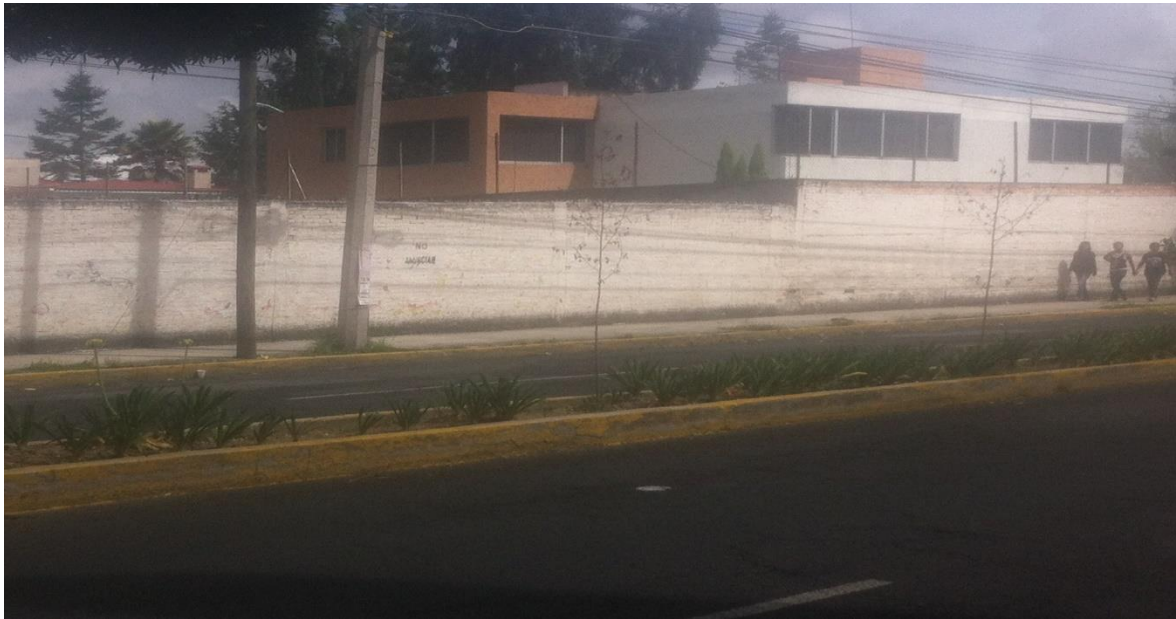
Imagen 12.- Barda Perimetral exterior al conjunto Urbano.
