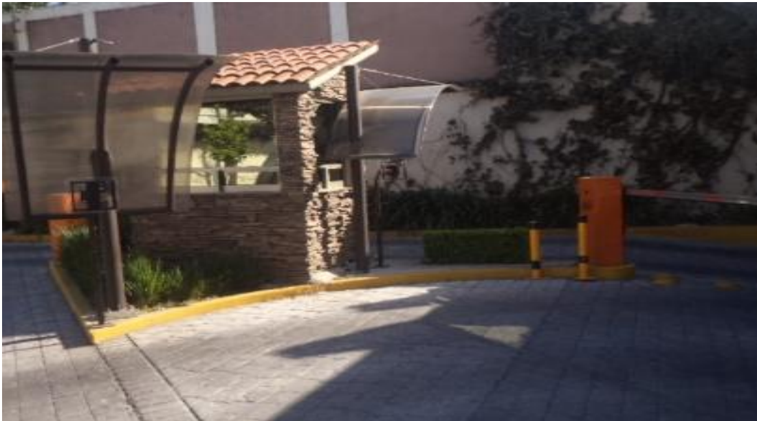
Imagen 4.- Caseta de Vigilancia.
