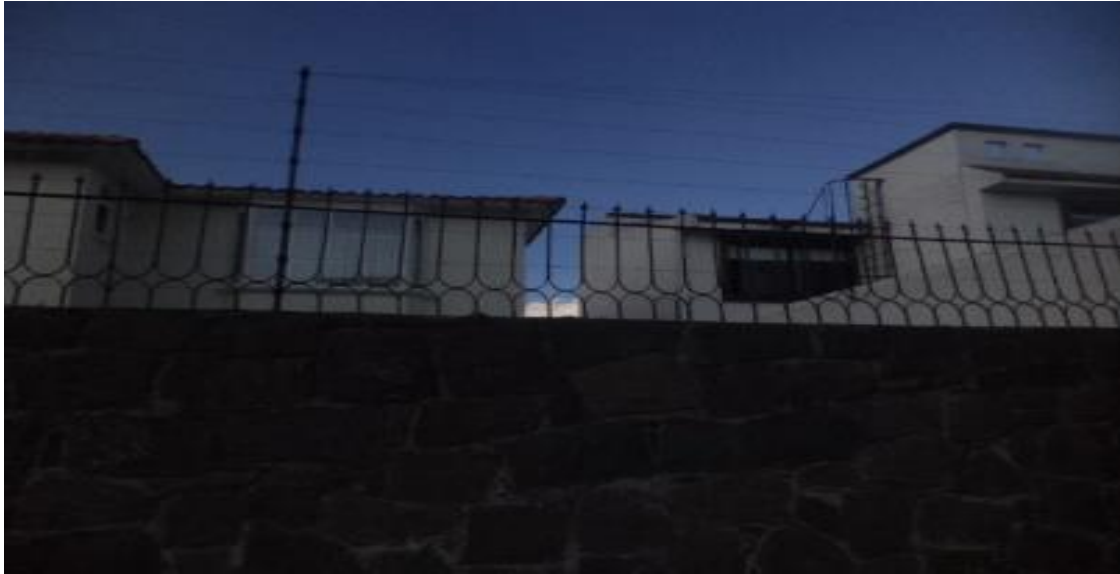
Imagen 7.- Barda Perimetral al exterior de conjunto urbano.
