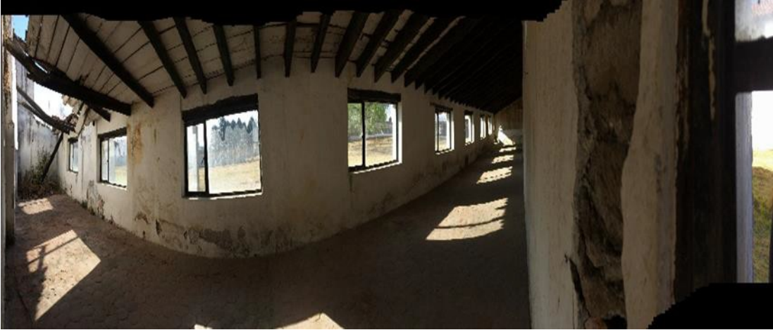
Fotografía 22. Fotografía panorámica del salón de fiestas. Tomada en la ex-hacienda de Atenco, por Claudia Lozada Esquivel el 17 de marzo de 2017.
