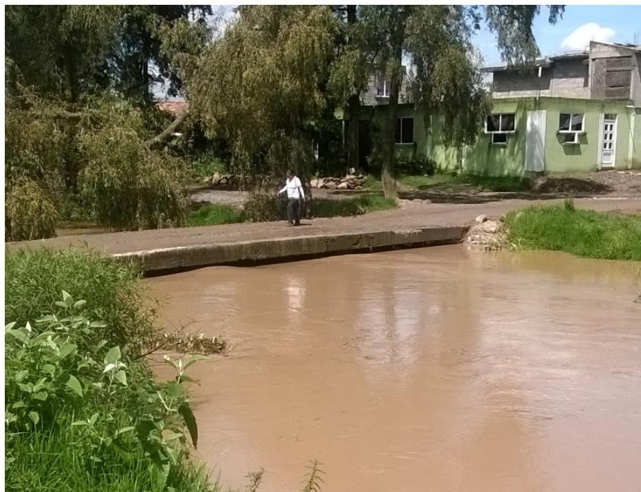
Figura 7.13. Vista del río alcanzando el puente.
