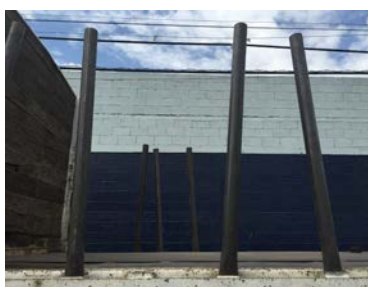
Figura 2.20. Estacas para sujeción de carga
