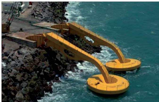
Figura 1. Prototipo de planta undimotriz “on-shore”, posible de instalar en los acantilados veracruzanos.
