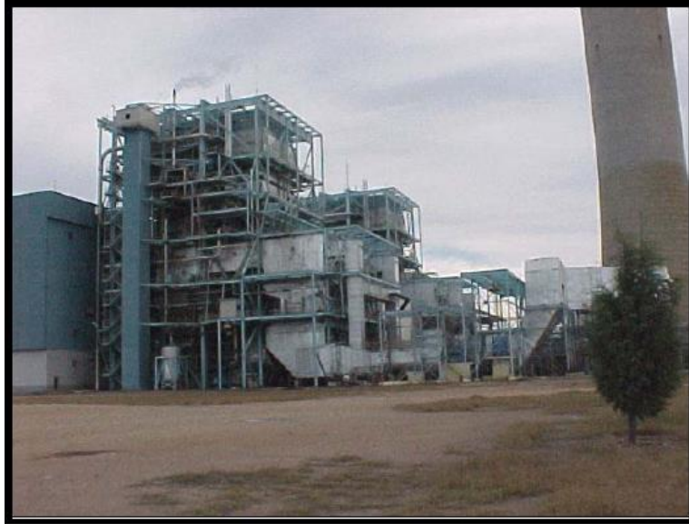
Figura 2.10. Central Termoeléctrica Villa de Reyes.
