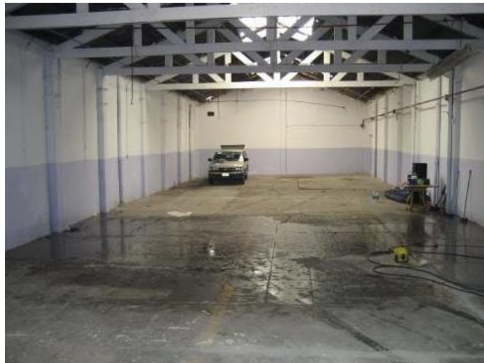
Figura 20. Vista interna de la fábrica.
