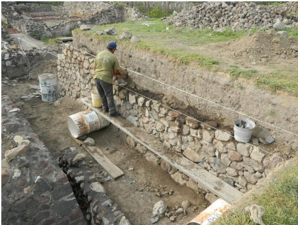
**fotografía 35.- Muro seco en talud.**
