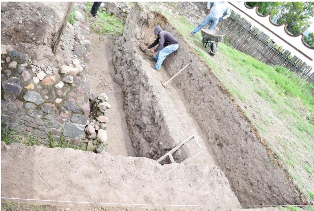
**fotografía 33.- Excavación de 1m. para evitar el derrumbe del perfil.**
