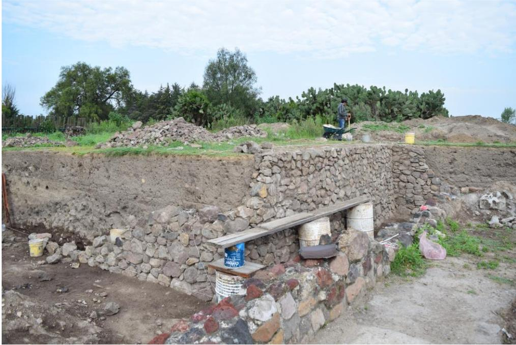
**fotografía 34.- Muro seco en talud.**
