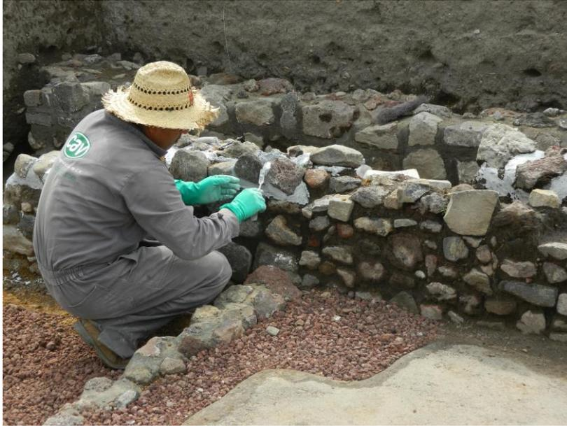
**fotografía 38.- Consolidación de muro prehispánico.**
