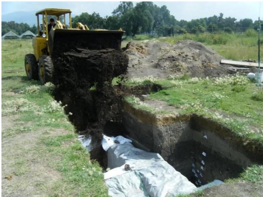
**fotografía 22.- Relleno de la ampliación norte con trascabo.**
