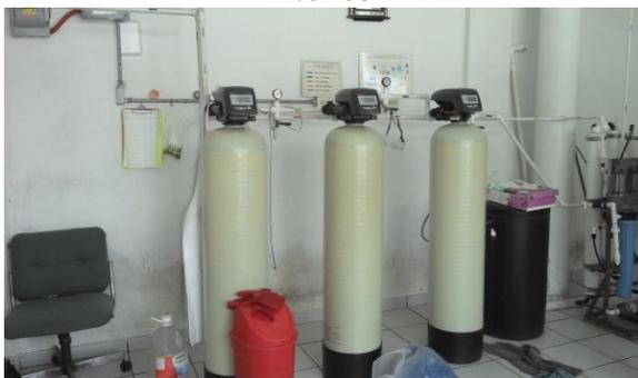
**Figura 41. Filtros de agua a base de carbón activo, Lerma**
