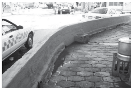
Figura 7. Muro en la entrada de negocios.
