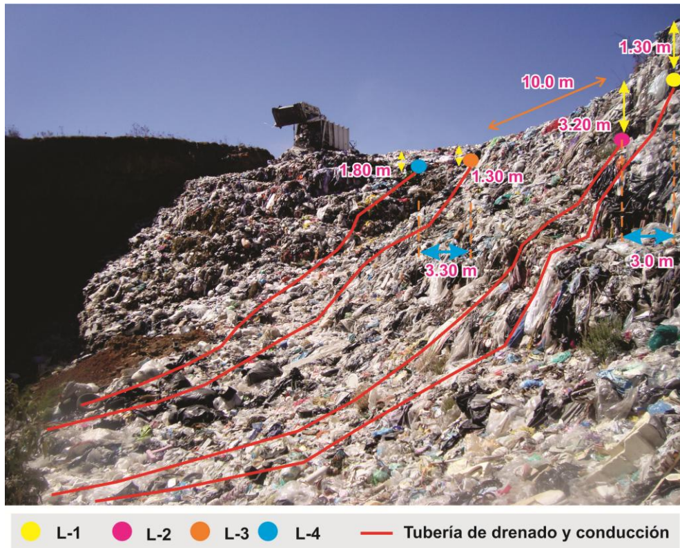
Figura 3.2. Ubicación de los cuatro lisímetros de libre drenado colocados en la celda de RS, así mismo, en esta figura se representó con una línea roja la tubería por donde los lixiviados fueron conducidos hasta cada uno de los tanques de almacenamiento ocultos en el fondo del vertedero. Fuente: Elaboración propia.
