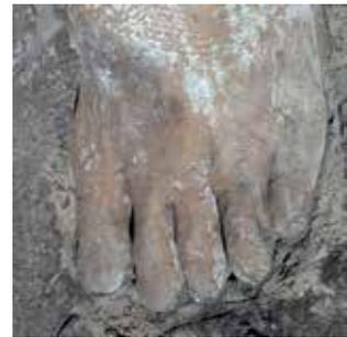
**IMAGEN 22.** *Monumento a la Autonomía Universitaria*, localizado en el Jardín de la Autonomía en la fachada oriente del Edificio de la Rectoría, UAEM. Muestra de la pérdida de la pátina artificial dejando al descubierto al metal base.
