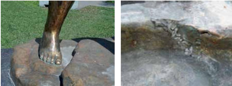
**IMAGEN 8.** En las imágenes, se pueden observar diferentes productos de oxidación: los de color verde azulado en el pie, los blanquecinos sobre la soldadura y manchas oscuras de pátina.
