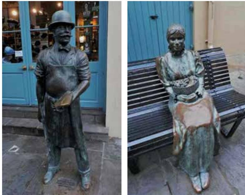
En este par de fotografías, se nota el color de la aleación base, el color marrón típico del bronce que se va a emplear sin recubrimientos artificiales. Se observan los productos de oxidación en las áreas que no están al alcance de los agentes de deterioro antropogénico. Las áreas pulimentadas se deben a la acción del contacto directo con los visitantes del lugar. Las estatuas se encuentran en áreas semicubiertas, la iluminación solar depende del cambio de posición solar estacional.
