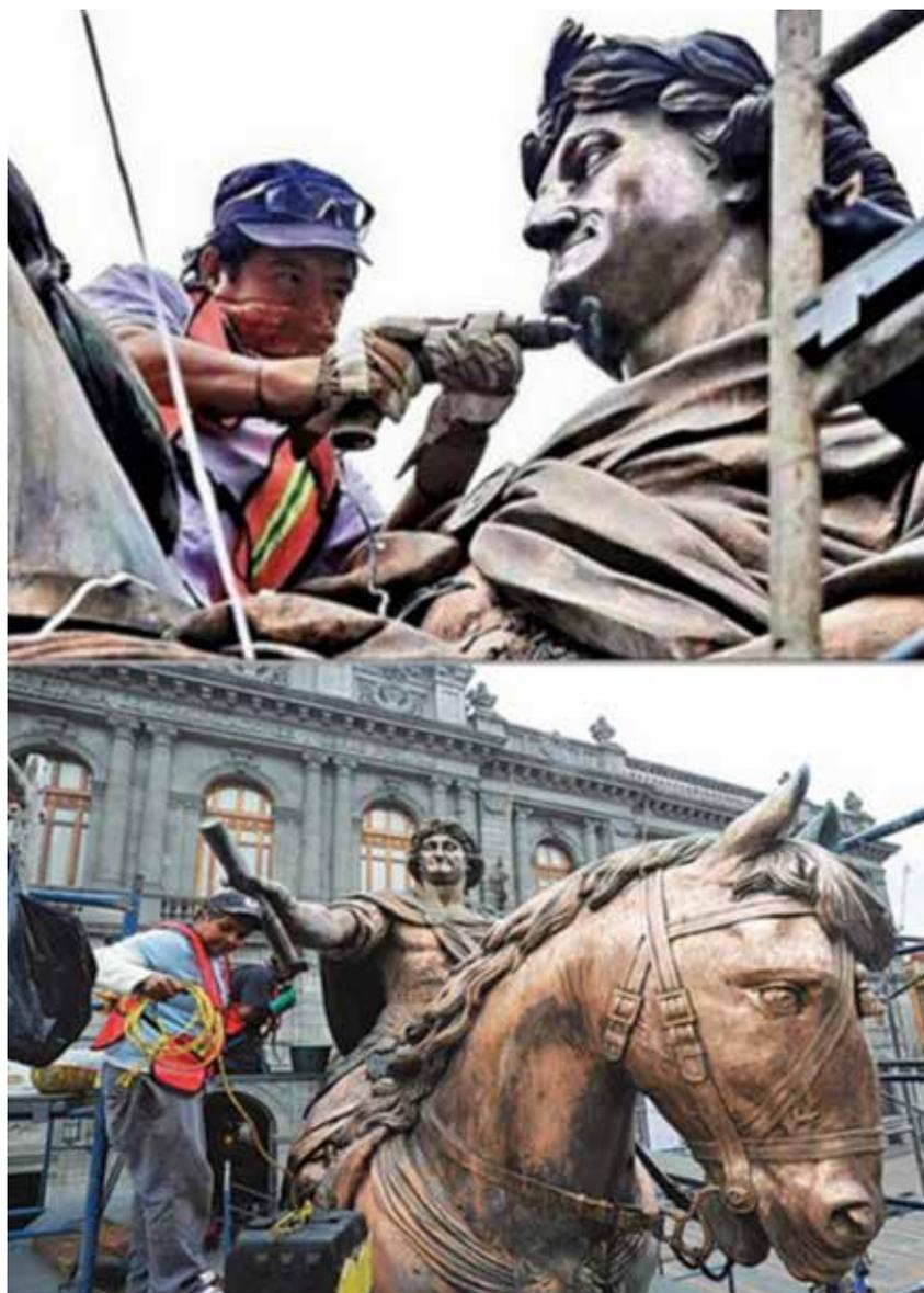
**IMAGEN 6.** En esta fotografía, se observa el decapado mecánico sobre la superficie de la escultura.
