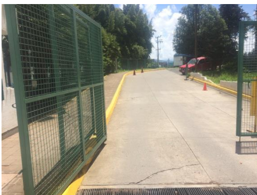
Imagen 25 - Acceso de calle a Hospital mediante rampa peatonal/vehicular
