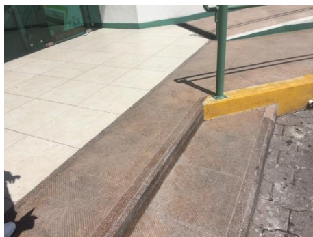
Imagen 3 - Acceso de nivel de calle a Clínica mediante escalones
