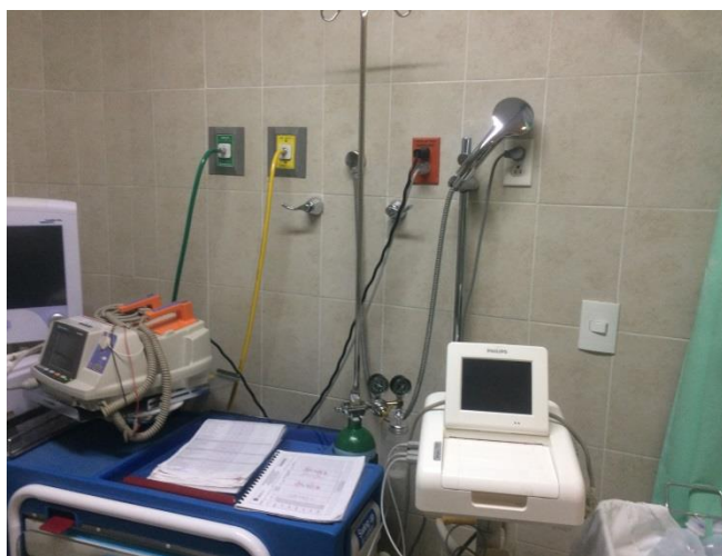
41._ Sanitario en sala de espera de urgencias
