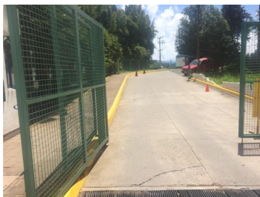
Imagen 25 - Acceso de calle a Hospital mediante rampa peatonal/vehicular
