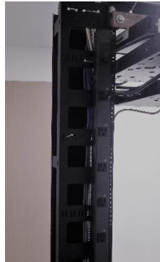
Figura 64. Organizador vertical y barra multi - contactos.
