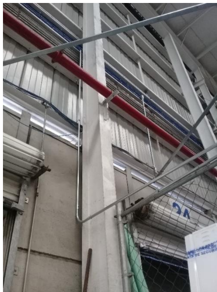
Figura 90. Instalación de tubería en cortina de zona A.
