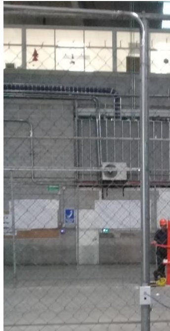
Figura 91. Instalación de tubería hacia la caja de red.
