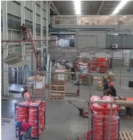
Figura 89. Seguimiento de instalación del cableado en zona de cortinas.
