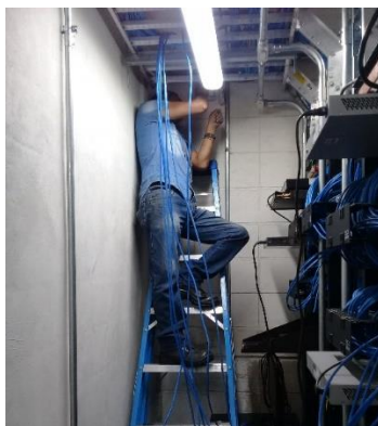
Figura 93. Instalación de cable UTP.
