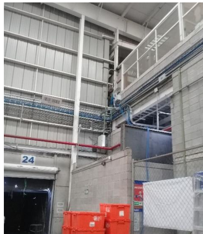
Figura 88. Instalación de cable UTP, inicio MDF SITE .
