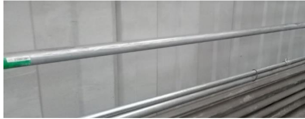
Figura 70. Instalación de tubería.
