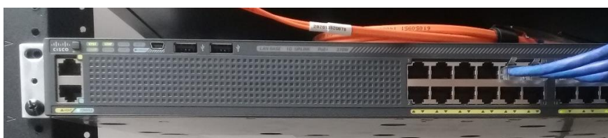
Figura 77. Instalación del switch Catalyst 2960 .
