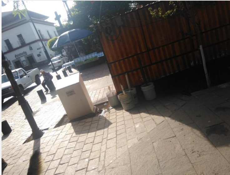
Foto No.2 Rampa de acceso
