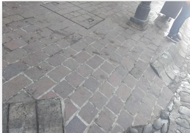
Foto No.1 Rampa de acceso
