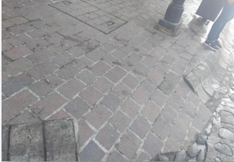
Foto No.1 Rampa de acceso
