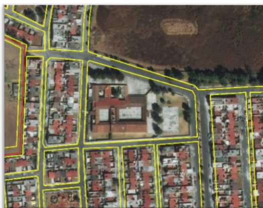
Figura 17. Escuela primaria y jardín de niños construidos dentro del conjunto habitacional SUTEYM-ALMOLOYA.
