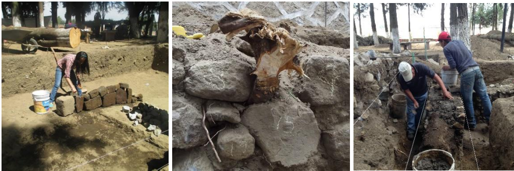
IMAGEN 51 PROCESO DE CONSOLIDACIÓN Y REINTEGRACIÓN DE ELEMENTOS ARQUITECTÓNICOS. FOTOGRAFÍA POR DANIEL GUEVARA ACOSTA Y ANA LAURA NAVARRO MARTÍNEZ
