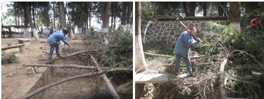
IMAGEN 50. COLOCACIÓN Y RETIRO DE ENTRAMADO. FOTOGRAFÍA POR DANIEL GUEVARA ACOSTA
