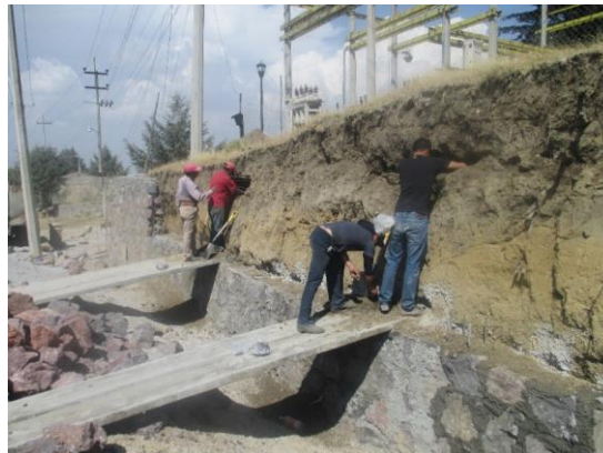
IMAGEN 46. EXCAVACIÓN FRONTAL DE FOSAS, PREVIO A SER CUBIERTAS POR LA BARDA DE CONTENCIÓN PERIMETRAL. FOTOGRAFÍA POR ANA LAURA NAVARRO MARTÍNEZ
